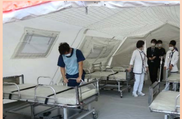
テント内部に災害用ベッドを設置
