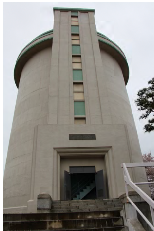
高さ32m、内径15m貯水容量3,534 m 3 円筒形の高架水槽で、ドーム状塔屋、頭頂部に4本柱の換気口があります。
