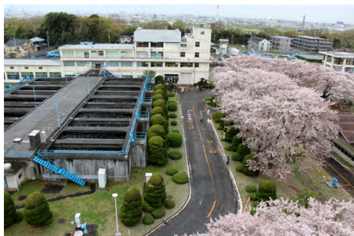
配水塔上部から栗山浄水場の風景桜が見事に咲き誇っていました。
