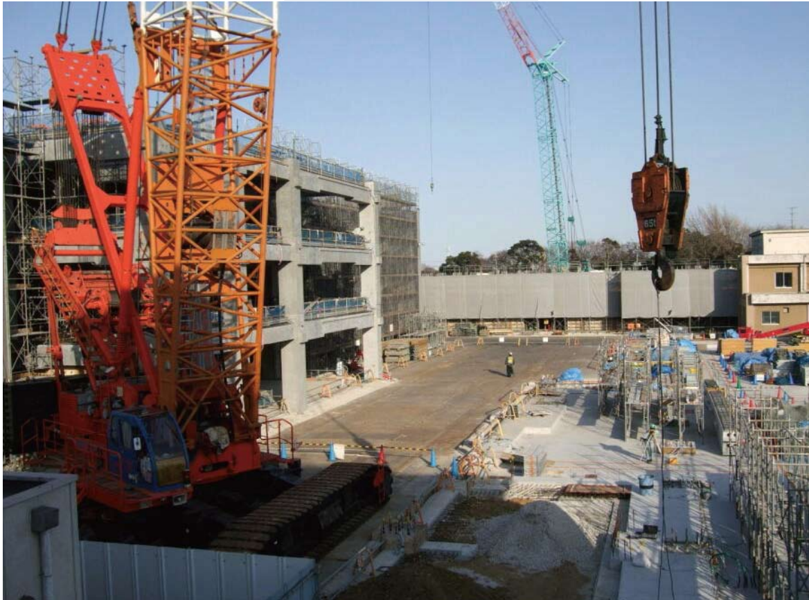
工事現場 (H23. 1. 28撮影)
